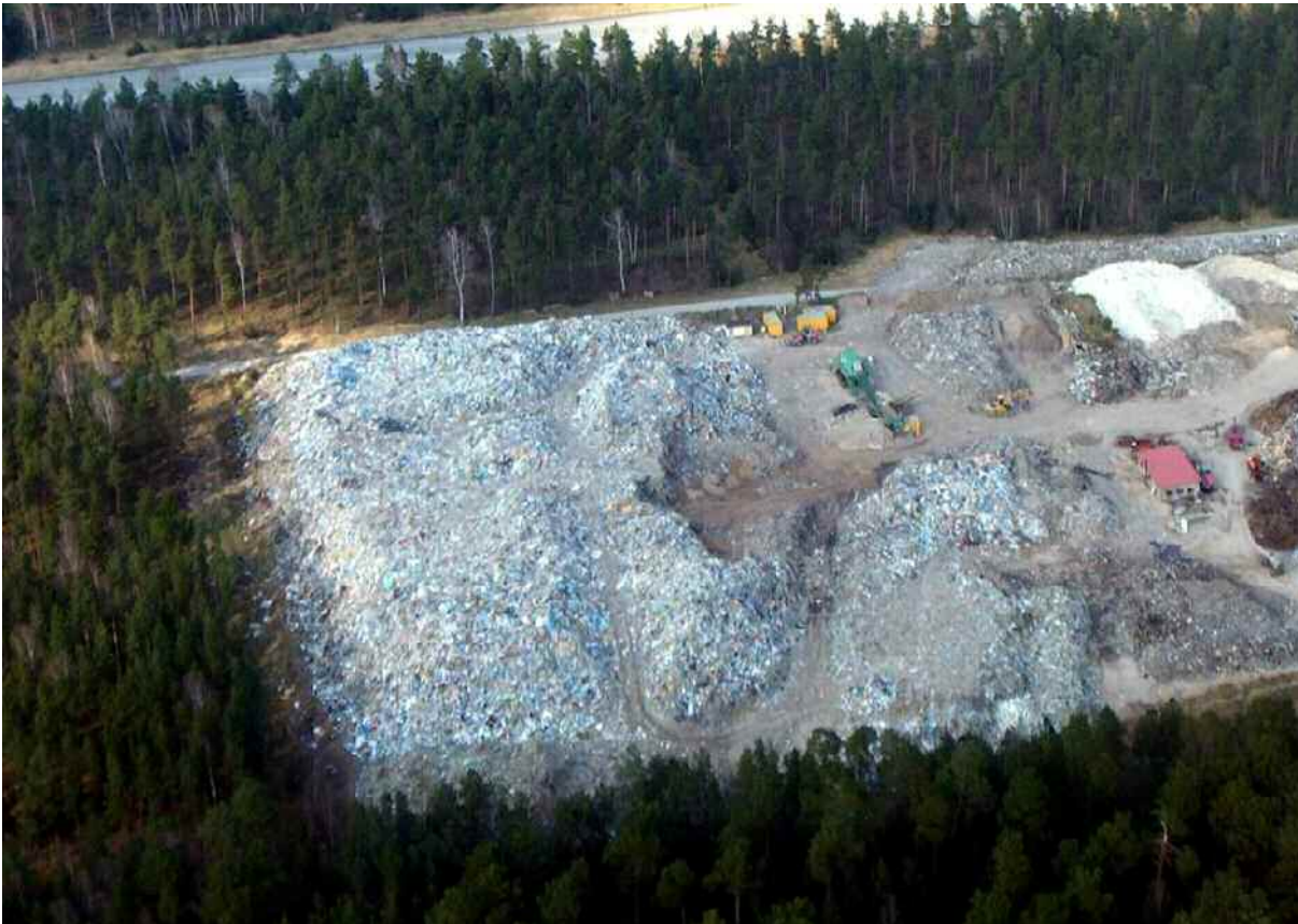
Abb.1. Recycling-Zwischenlager für Kunststoffe (Quelle: LUA Brandenburg)
